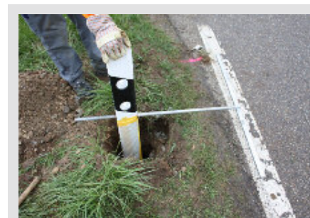
Bild 6: Hilfsmittel zur Herstellung der Fundamente (Foto: Ostalbkreis)
